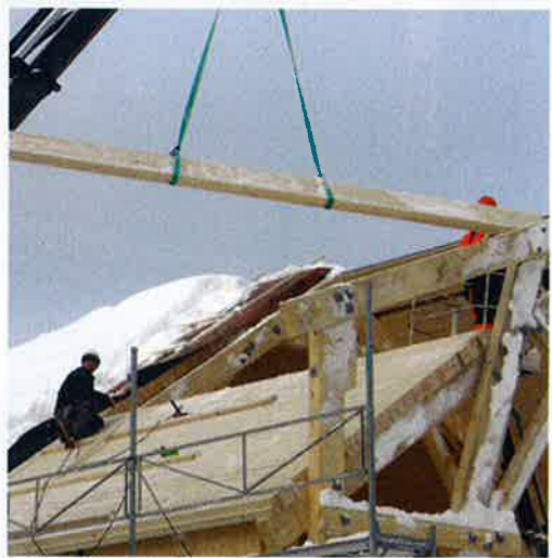
6 m lange massivtrelementer legges på taket med kran. Nederst til venstre: Annekset til hallen blir byggvarerom og spiserom for ansatte.
